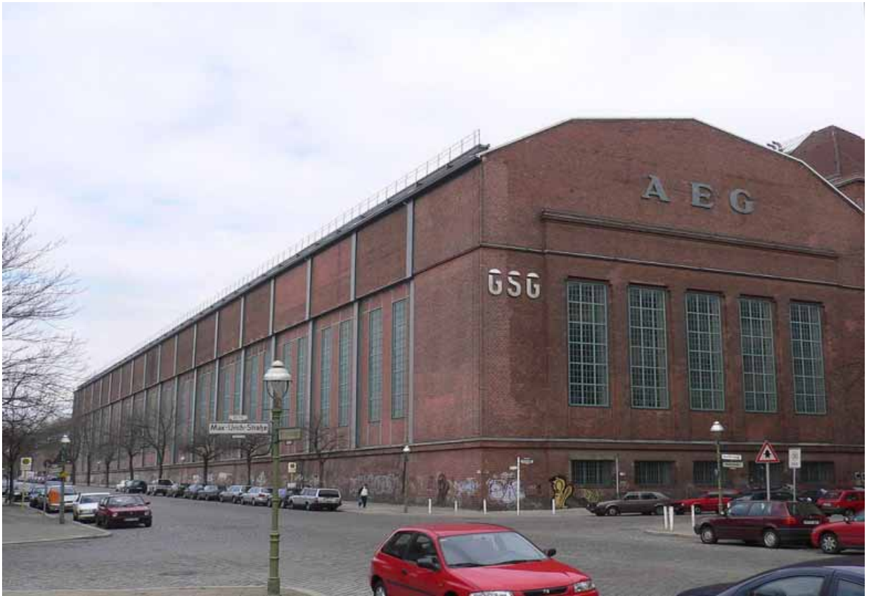
Рисунок А. 263 – Здание турбинной фабрики АЕГ. Turbine Fabrik, Humbolthain Peter Behrens (1909–1912)
